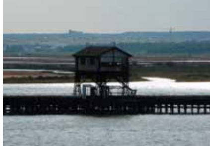
Appontement pour le chargement du minéral de Tharsis à Huelva.
