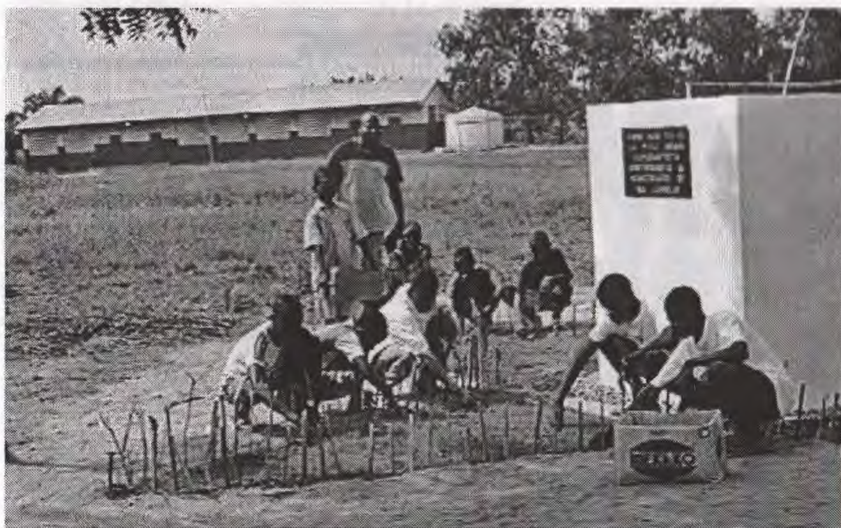
Op de voorgrond: één van de hoeken van de ster (monument) wordt afgewerkt. Op de achtergrond: het schoolgebouw 'Jules Verstraeten'.
